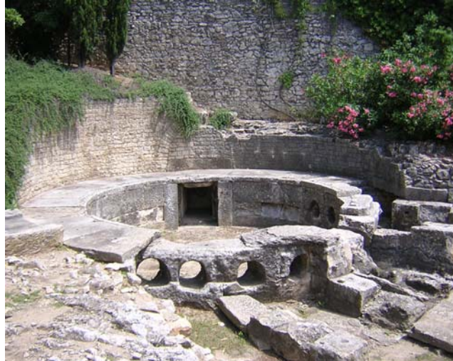
Figura 4: Resti del castello di distribuzione della città di Nîmes (Fonte: archivio Temporelli)
