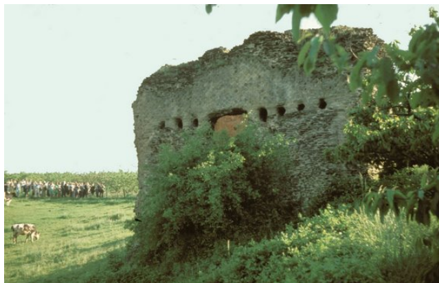
Figura 3: Resti della vasca di carico del sifone utilizzato nell'acquedotto romano di Gier – Lione; ben visibili i fori dai quali partivano i nove tubi di piombo per superare la valle Durèze, ampia oltre 700 metri e profonda quasi 80 metri (Fonte: archivio Dr. Fahlbusch H.)
